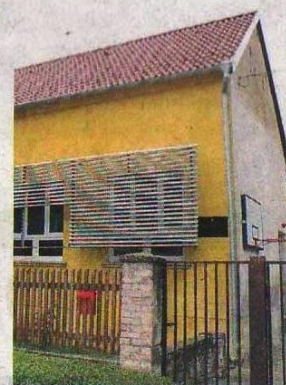
Škola je obnovljena
